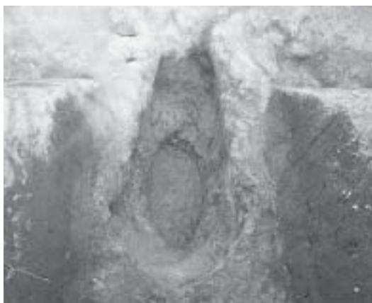
文中写真3 SK50貼床除去後完掘状況 (西から)
