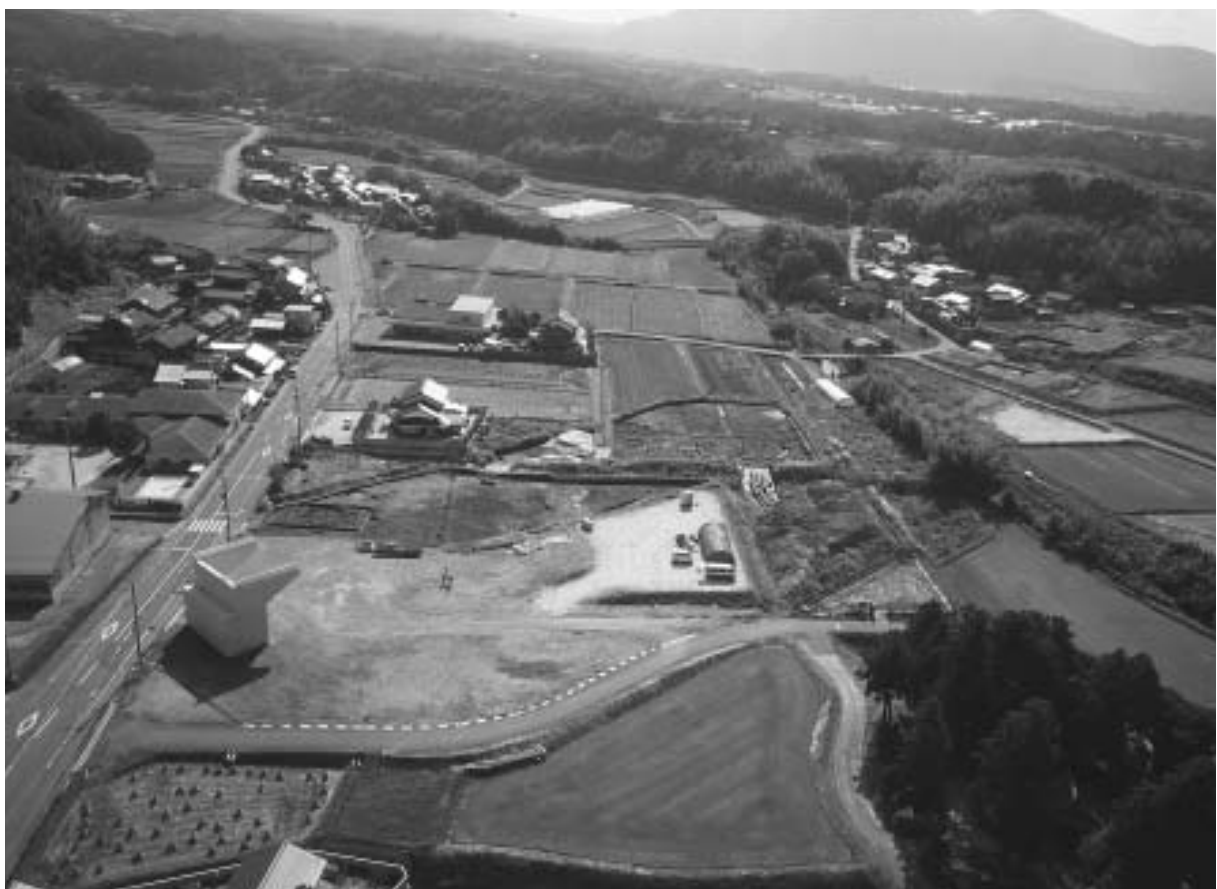
2 調査地近景4 2004年度調査後（北から）
