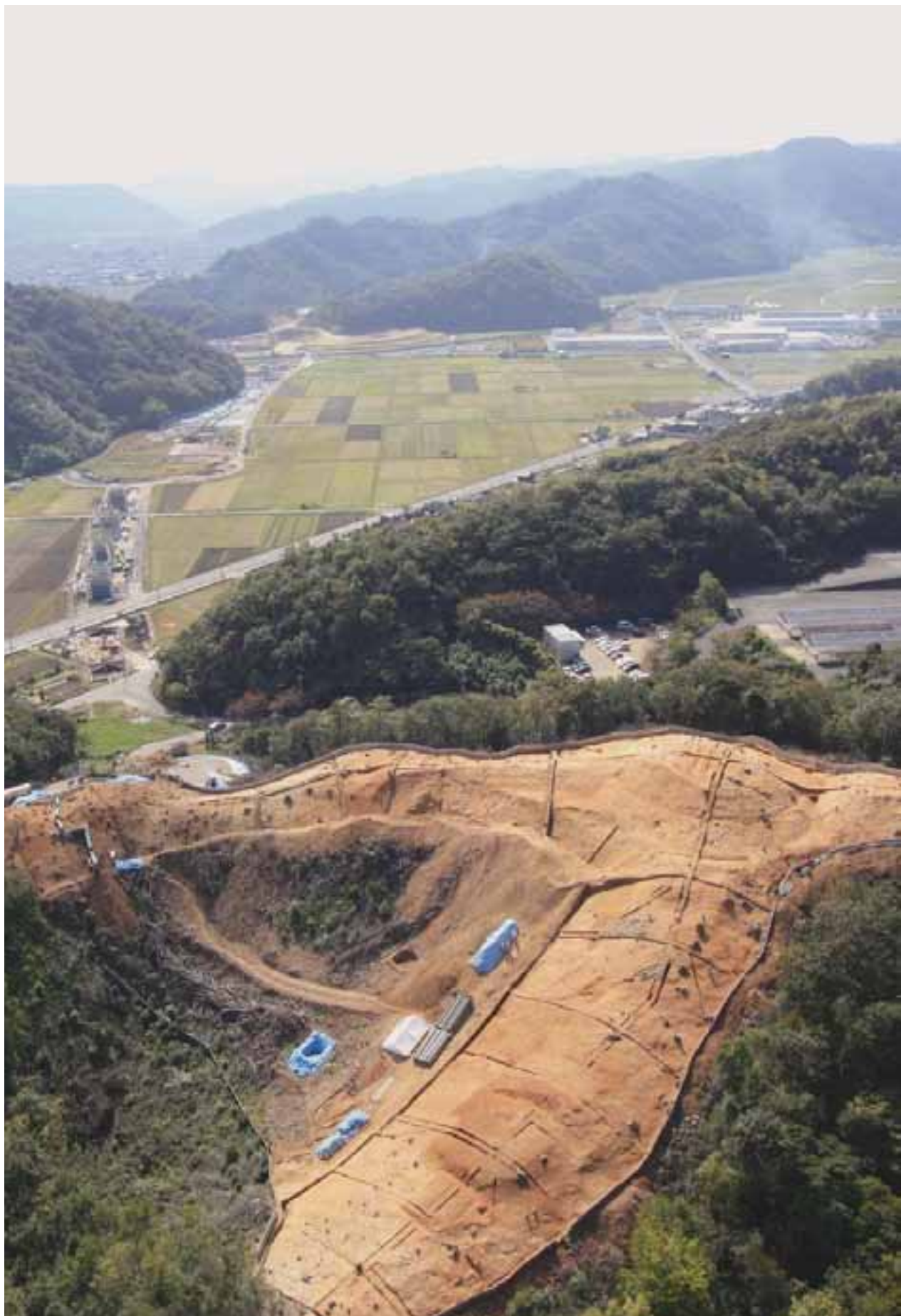
調査地遠景（北から）
