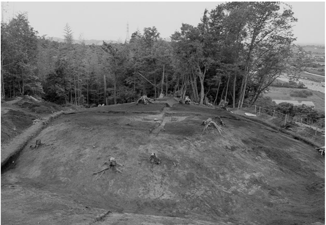
2. 越敷山49号墳盛土除去後(南から)
