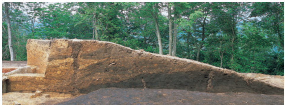
4. 越敷山51号墳墳丘断面(南北ベルト南側、南西から)
