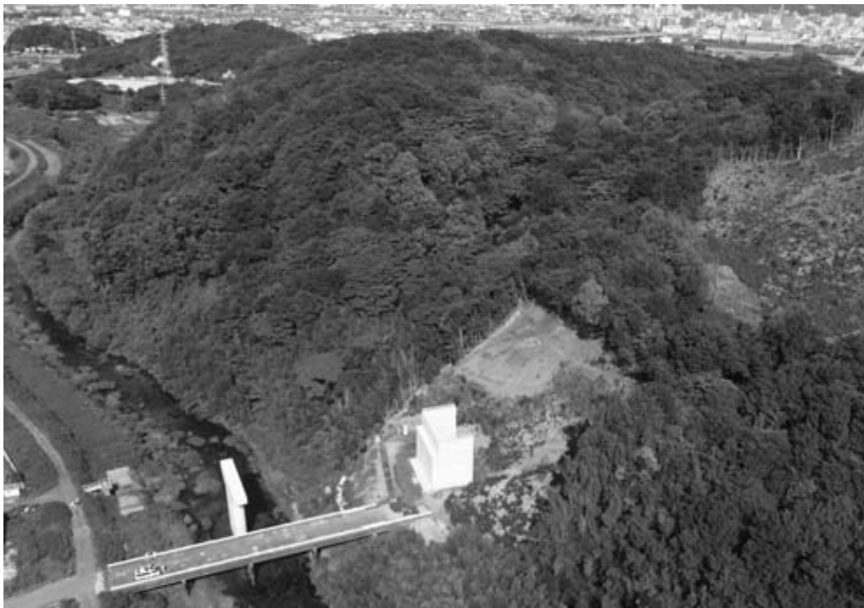
1 調査地および古海古墳群：調査後の遠景（南西から）
