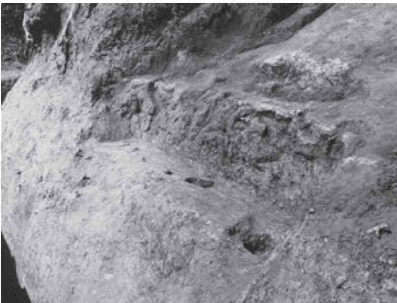
4 SI1 貼床除去状況(南から)
