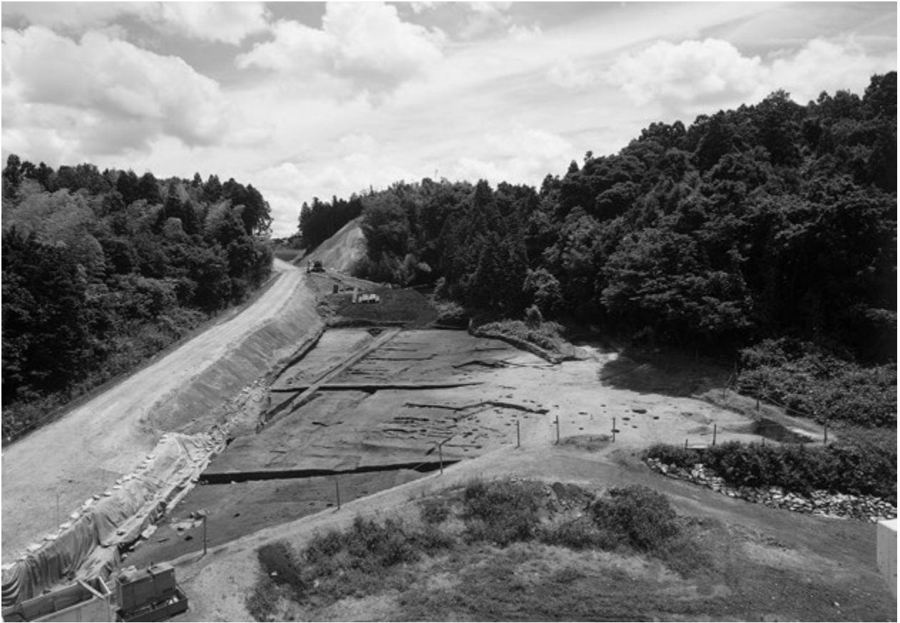
1. 第1遺構面全景(北西から)
