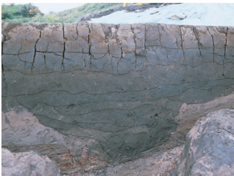
3. A-A断面SD33変形状況 (北西から)
