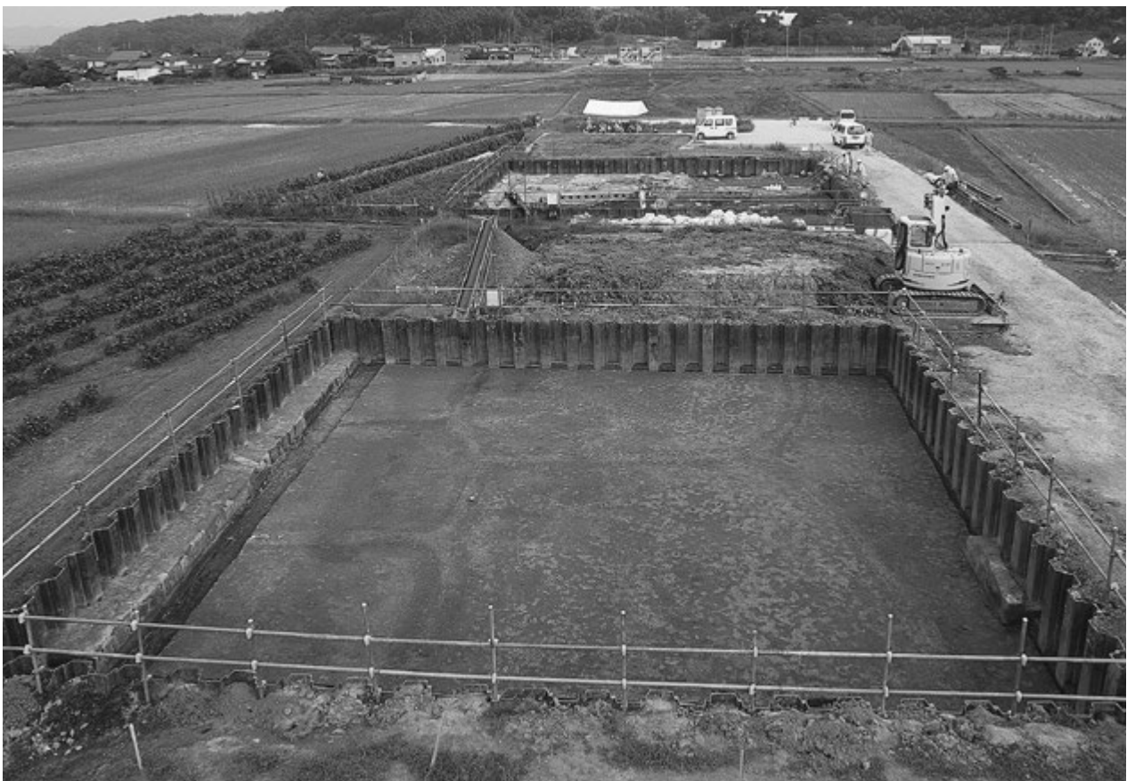
2. 1区第7面完掘状況(西から)
