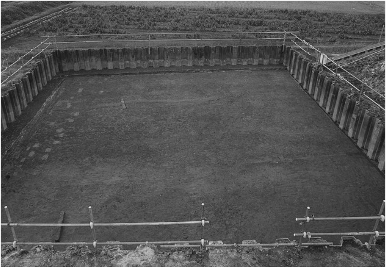
1. 1区第8-1面完掘状況(南から)
