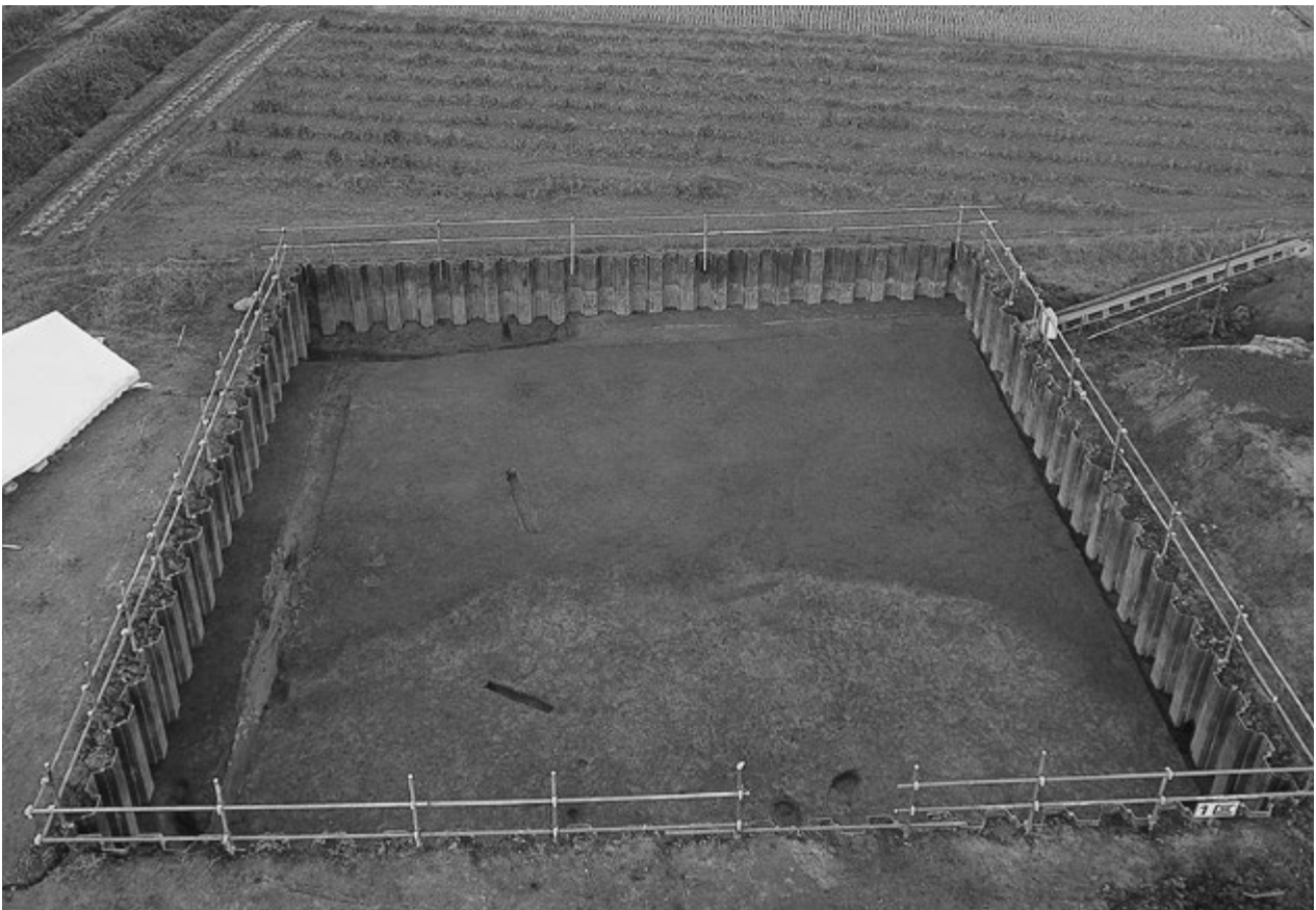
2. 1区第8-2面完掘状況(南から)
