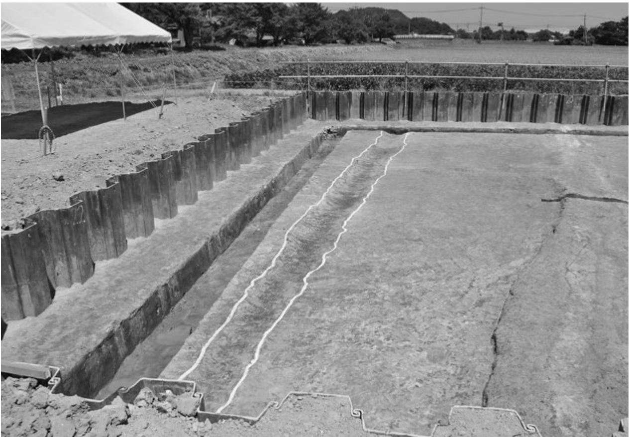
2. 1区1001溝完掘状況(南から)
