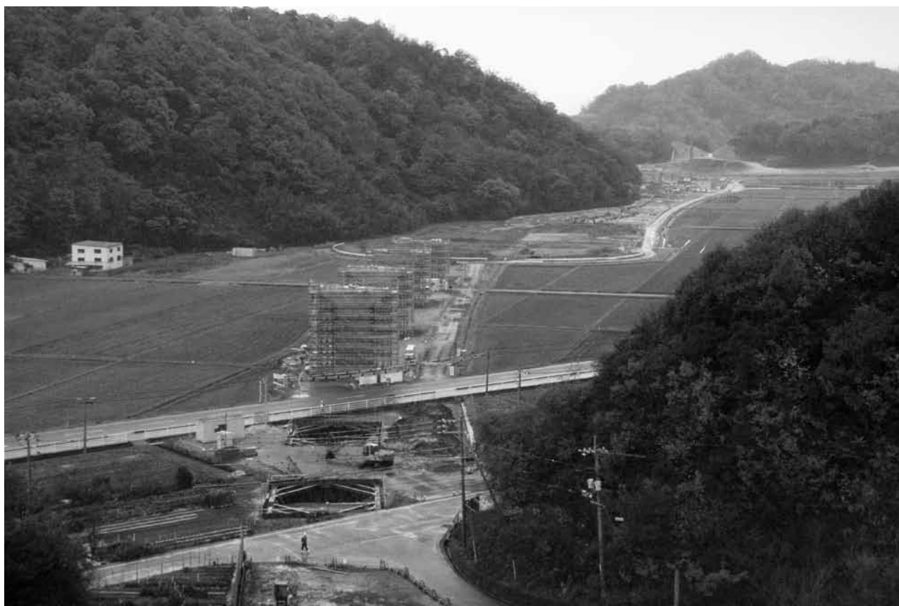
2 調査地：調査終了後（北から）
