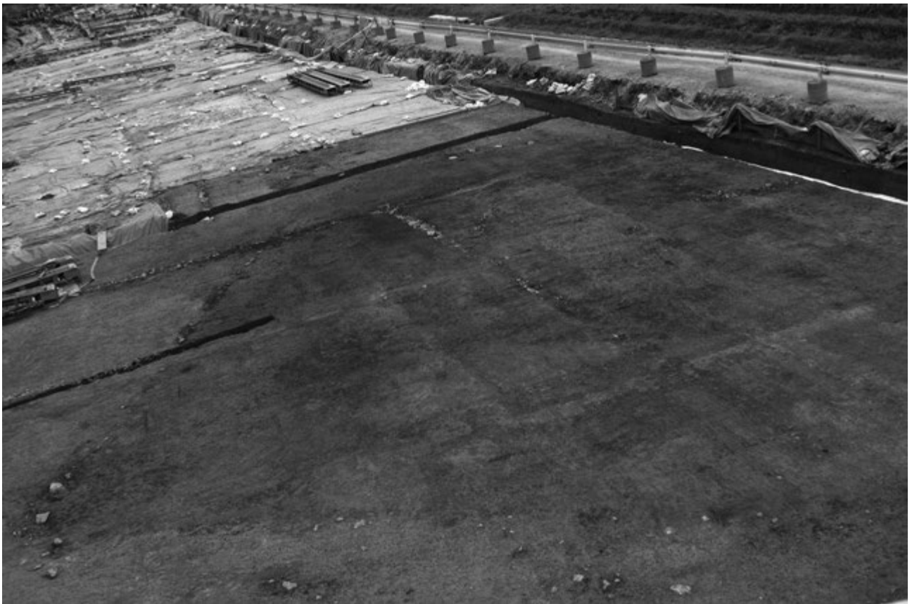
1 5区北西隅 第2a層掘削状況（北東から）
