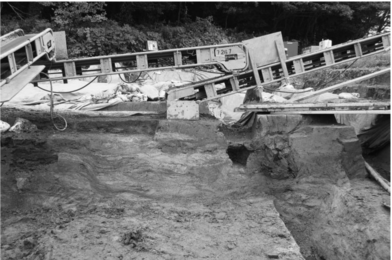
2 4落ち込み埋没土砂（南から）
