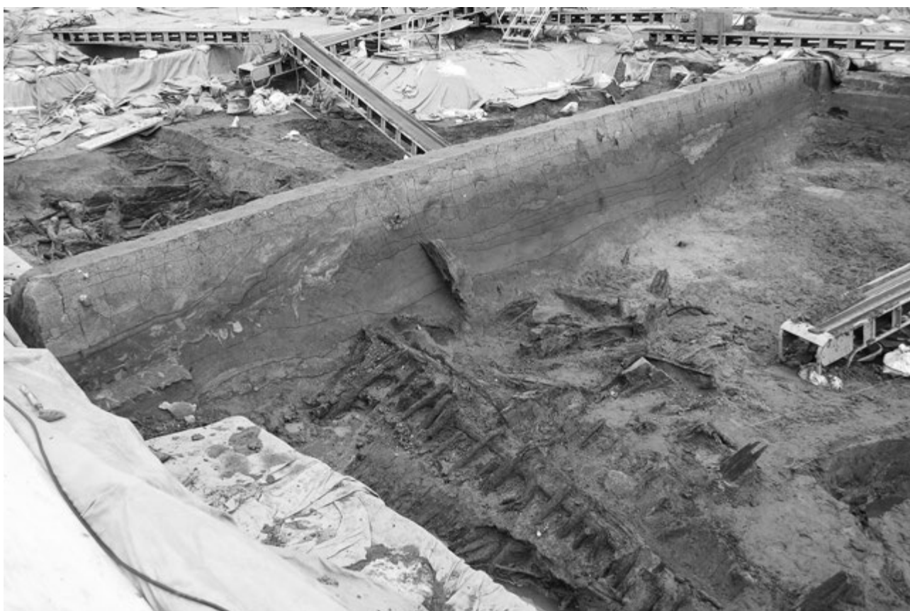
2 4落ち込みステージ12木製構造物南側（南西から）
