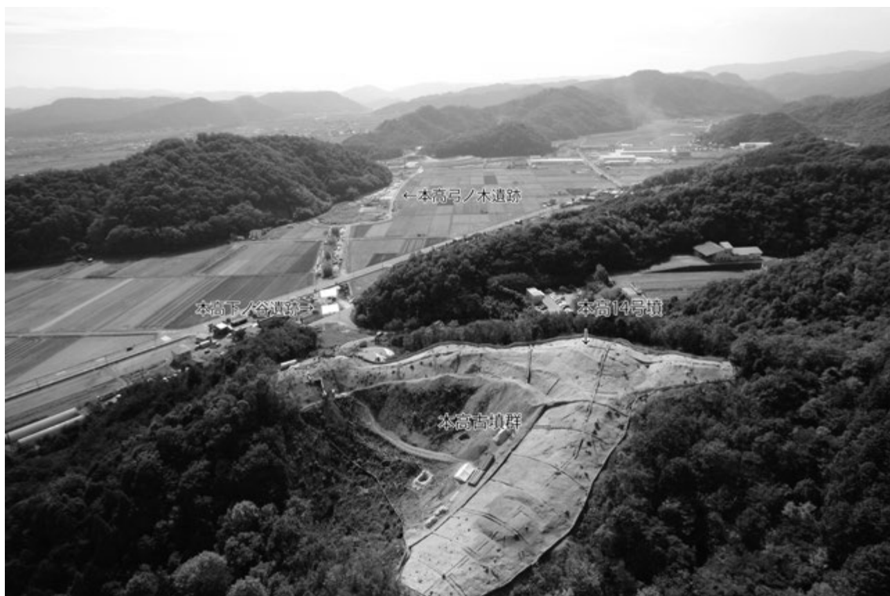
1 調査地遠景（北から）
