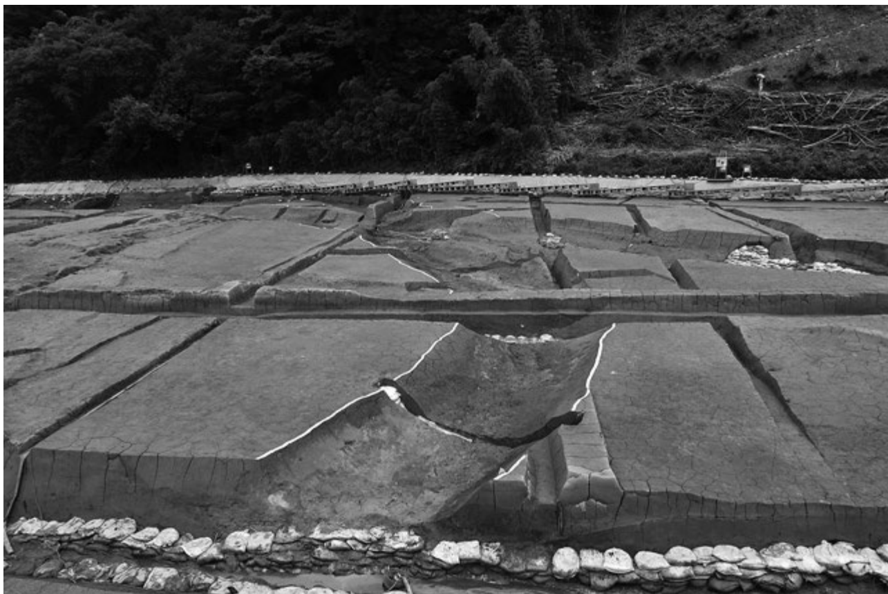
1 708 溝完掘状況 (西から)
