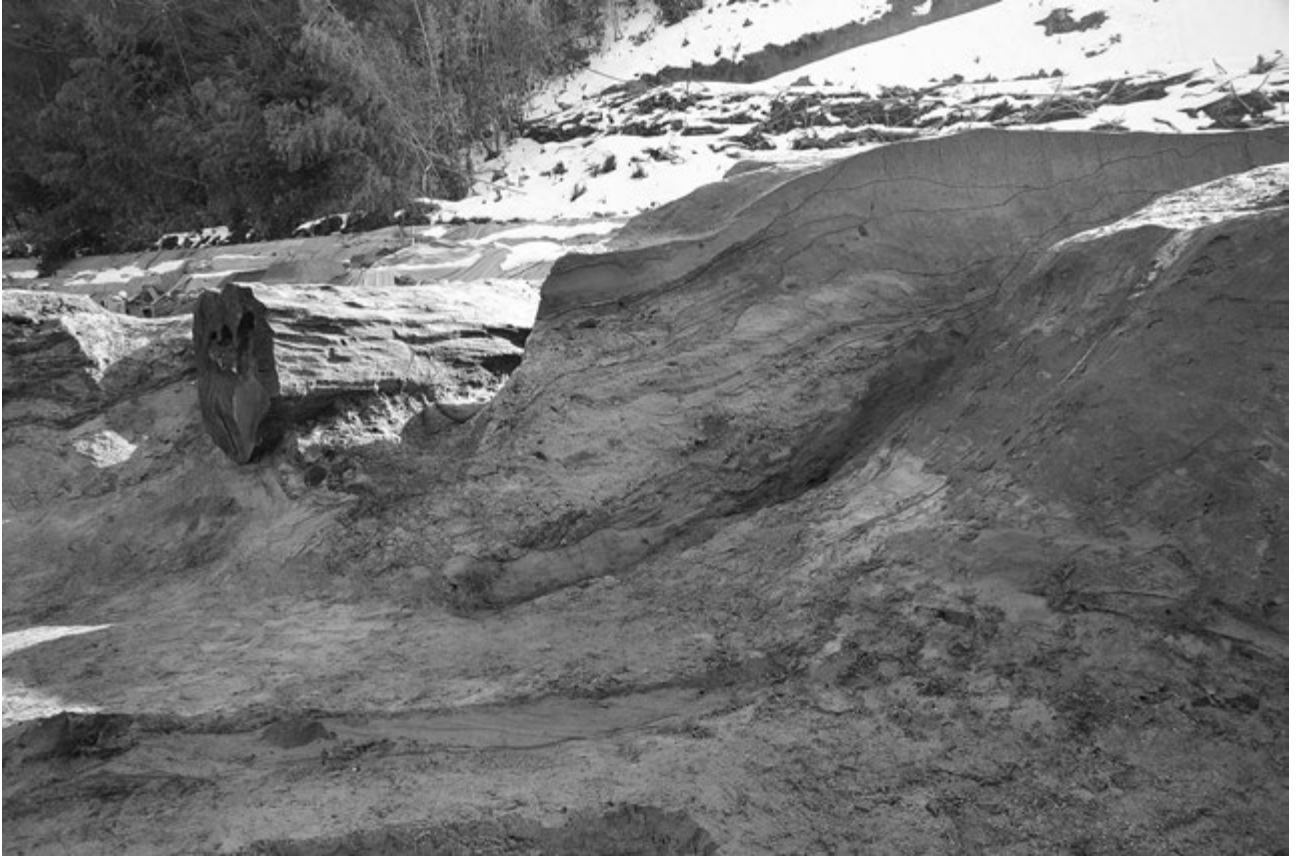
1 710 溝南側中層～下層土層断面 Y=-12,320 ライン (南西から)
