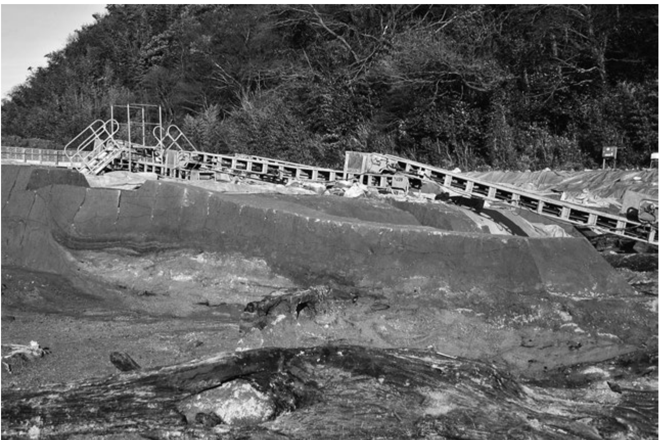
2 710溝北側上層～中層土層断面 Y=-12,320ライン（南西から）
