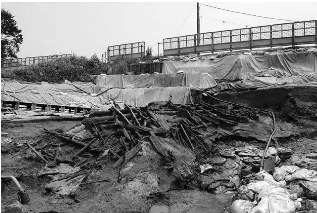
2 4落ち込みステージ2木製構造物（北西から）
