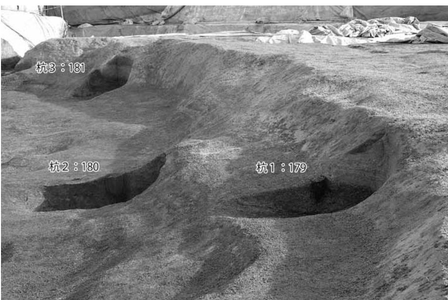
③ 8河川肩部 杭打設状況：南から
