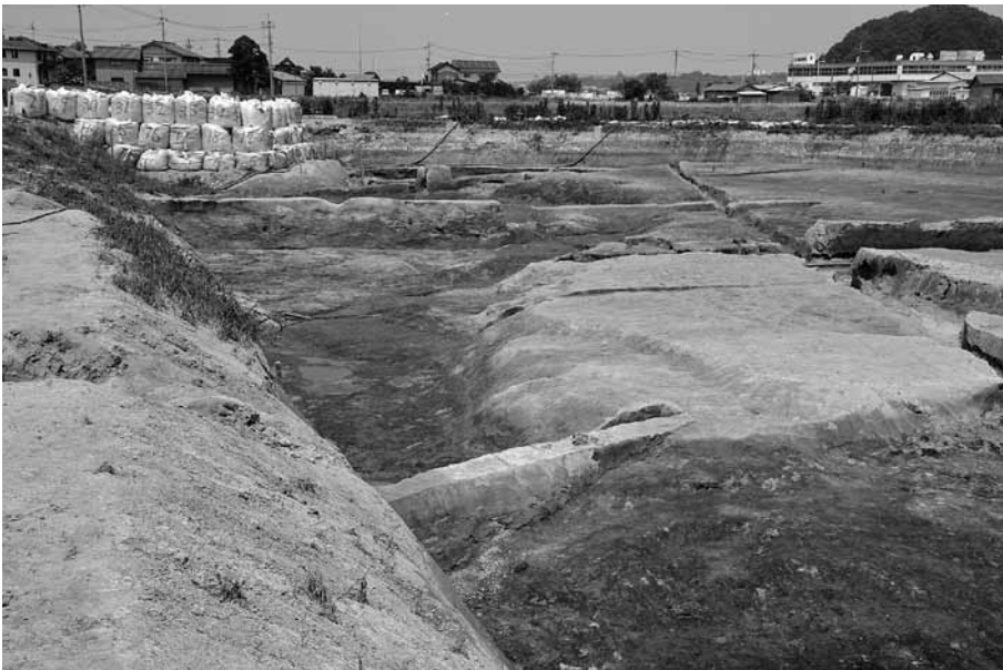
② 8河川 完掘状況 (調査区西側)：南から
