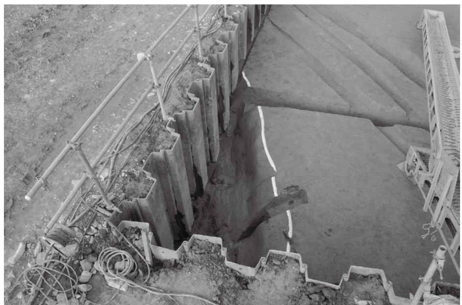
3 4-3区 34溝 完掘状況 (南から)
