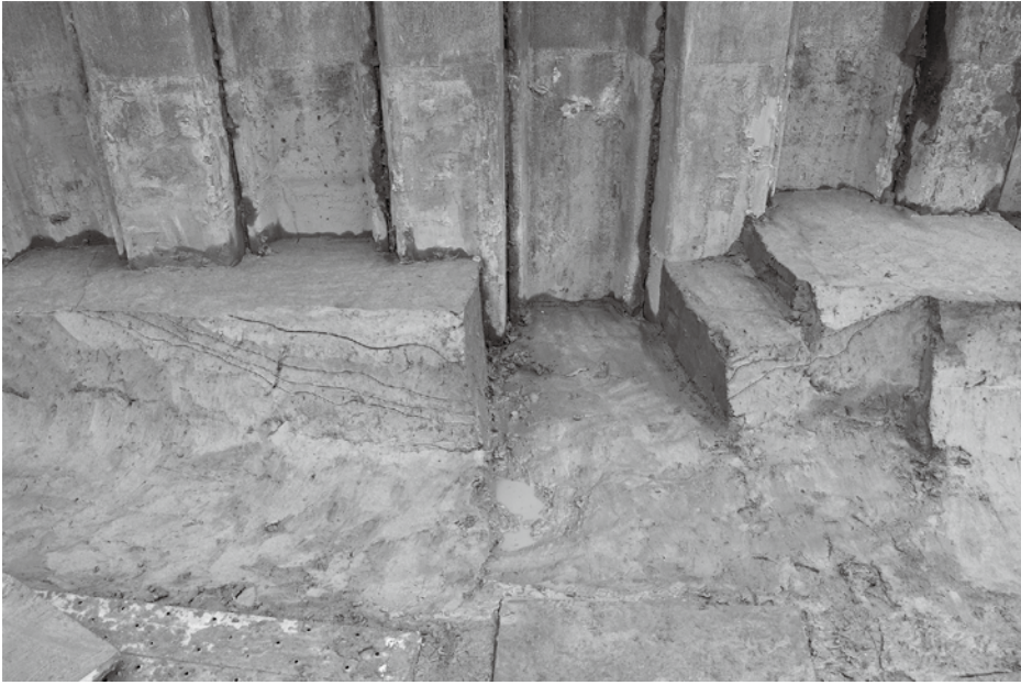
1 4-4区 55土坑 土層断面（西から）
