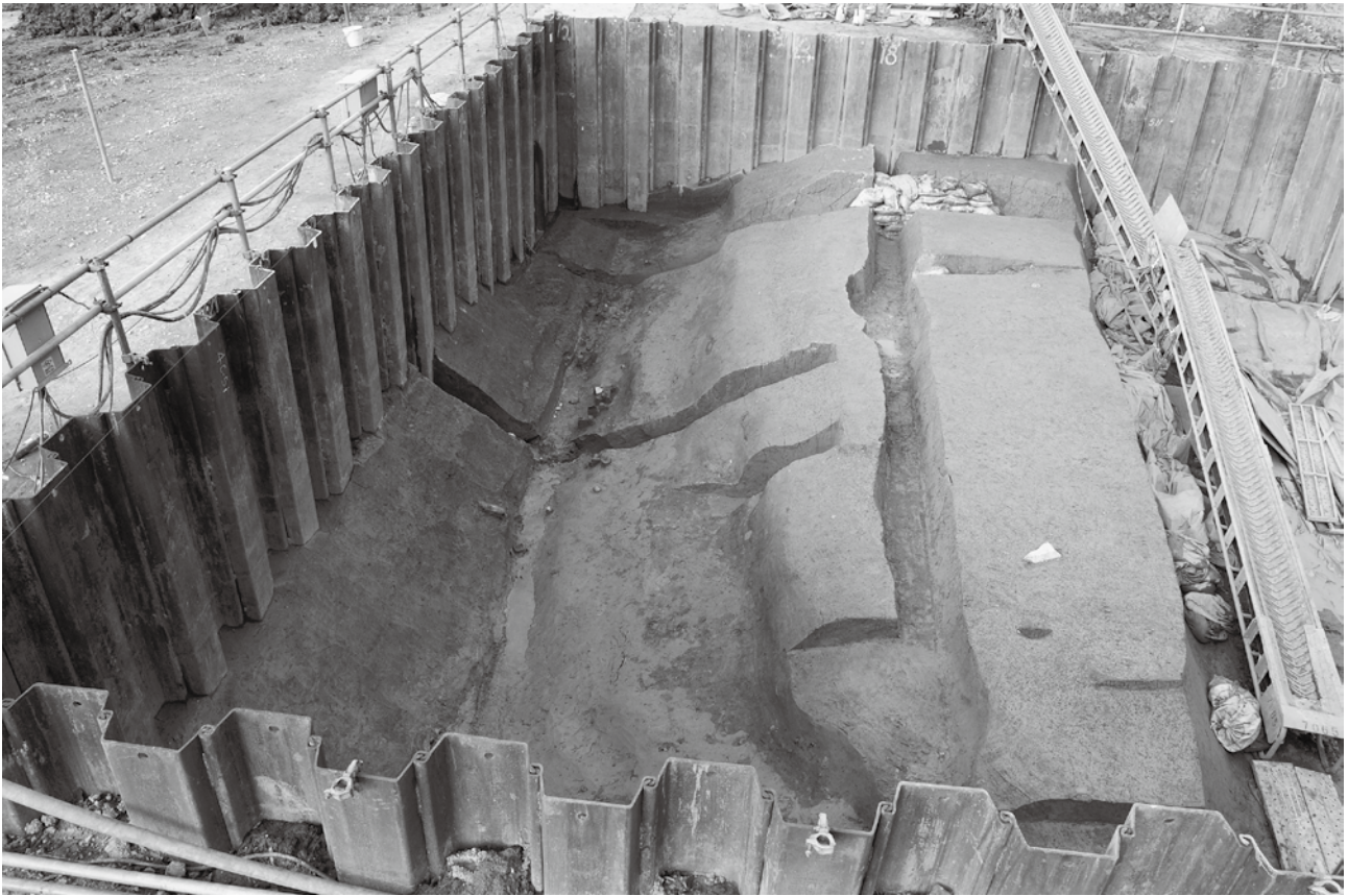
1 4-4区40溝 完掘状況 (南から)
