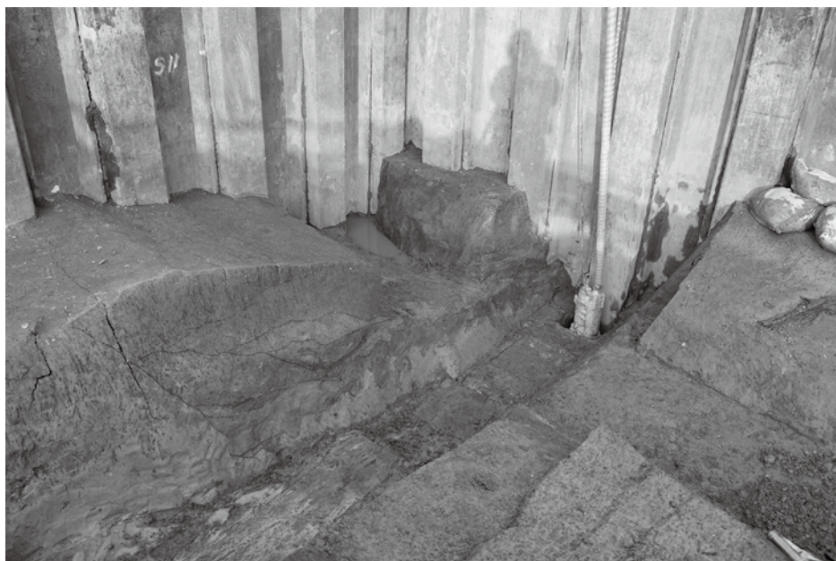
1 4-4区 9溝・41溝 土層 断面 (南西から)
