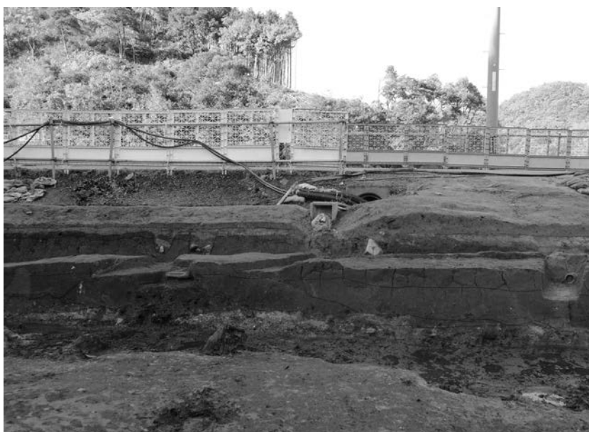
2 調査区西壁断面③（北から連続 撮影、東から）
