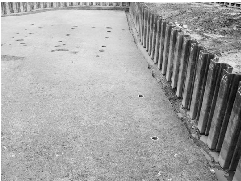
1 174・175ピット (北西から)
