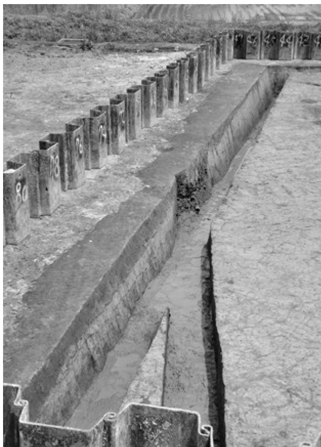
2 西壁断面(南から)
