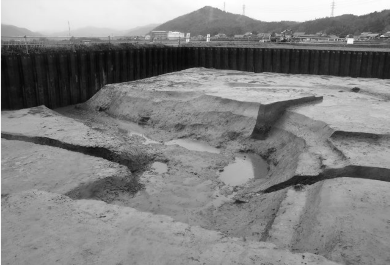
1 801流路完掘状況(東から)
