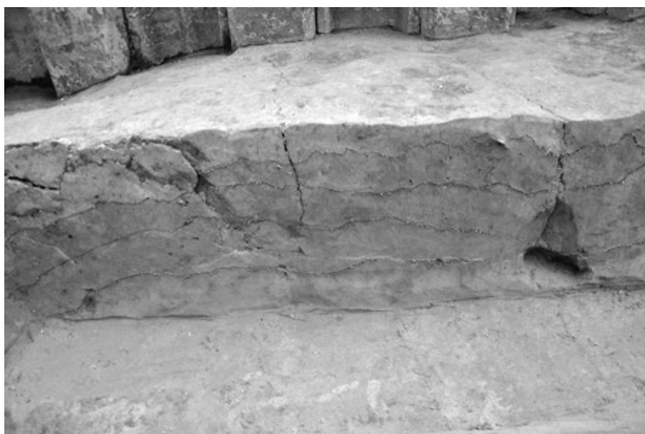
3 東壁北隅断面(5~7層) (北西から)
