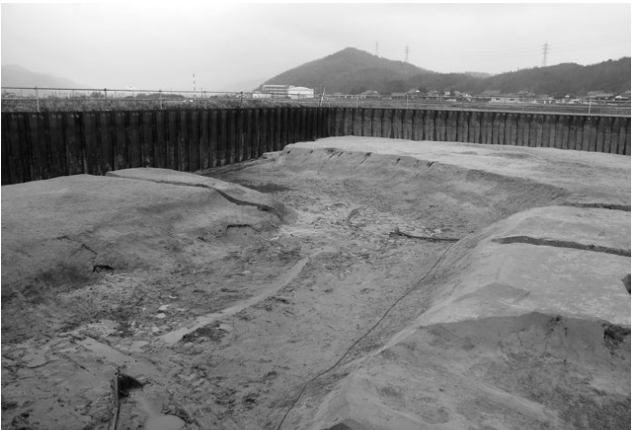
2 832流路完掘状況(北東から)
