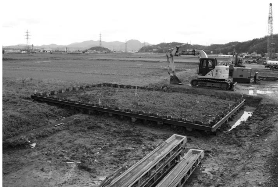
1 調査前近景 (南西から)
