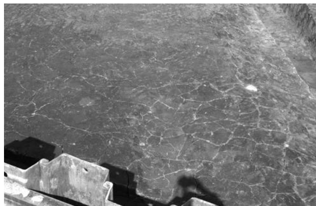
3 10溝完掘状況（西から）
