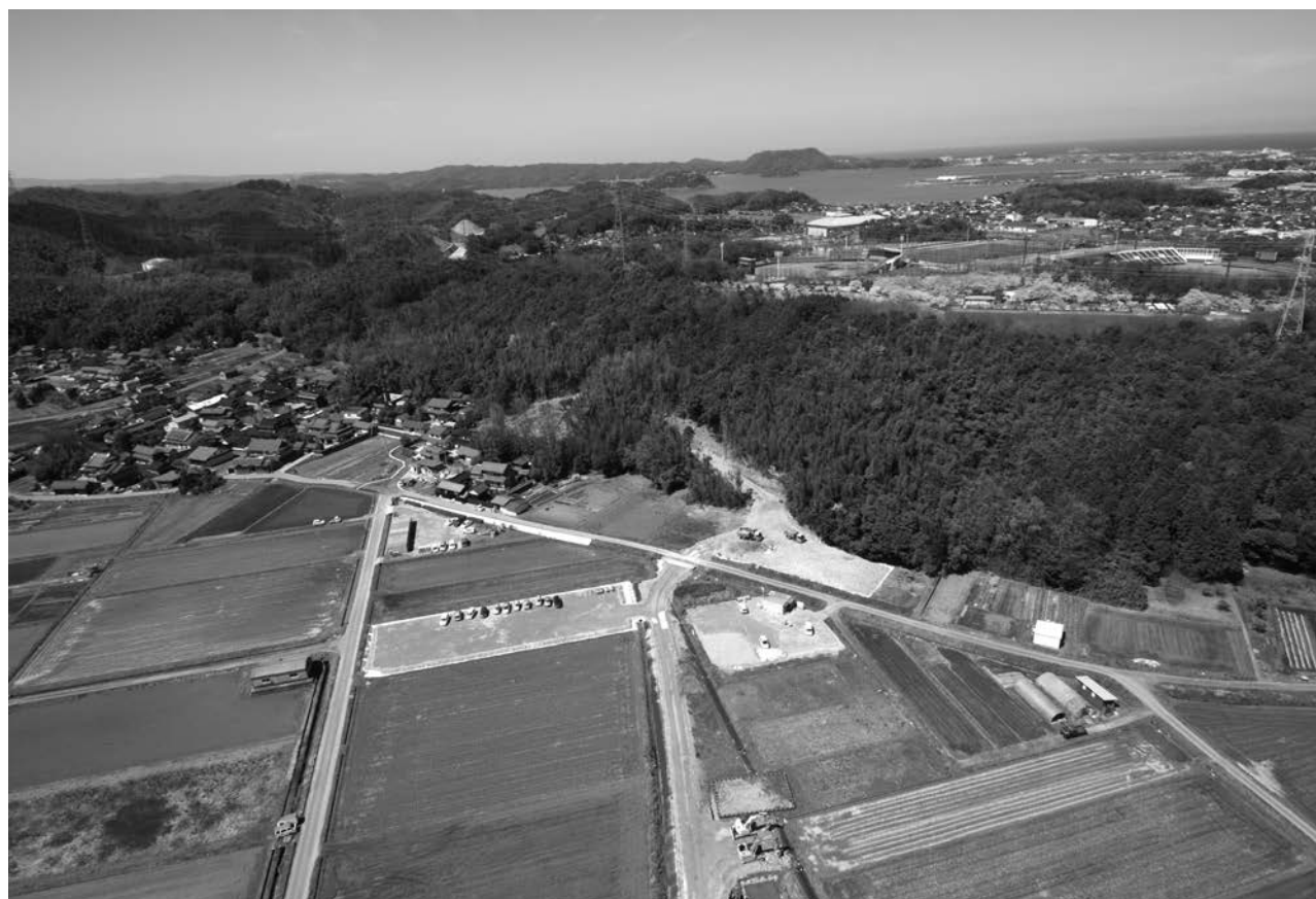
2 調査前遠景（東から）
